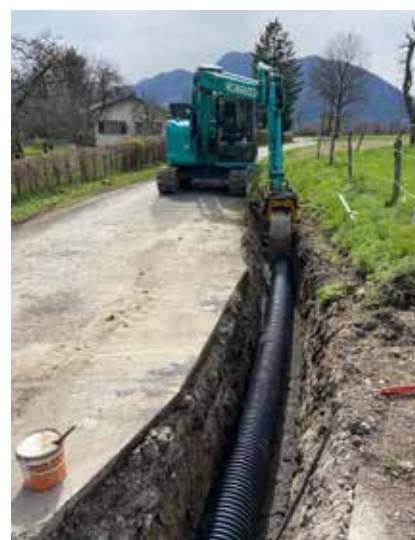
Installation-pose des canalisations
