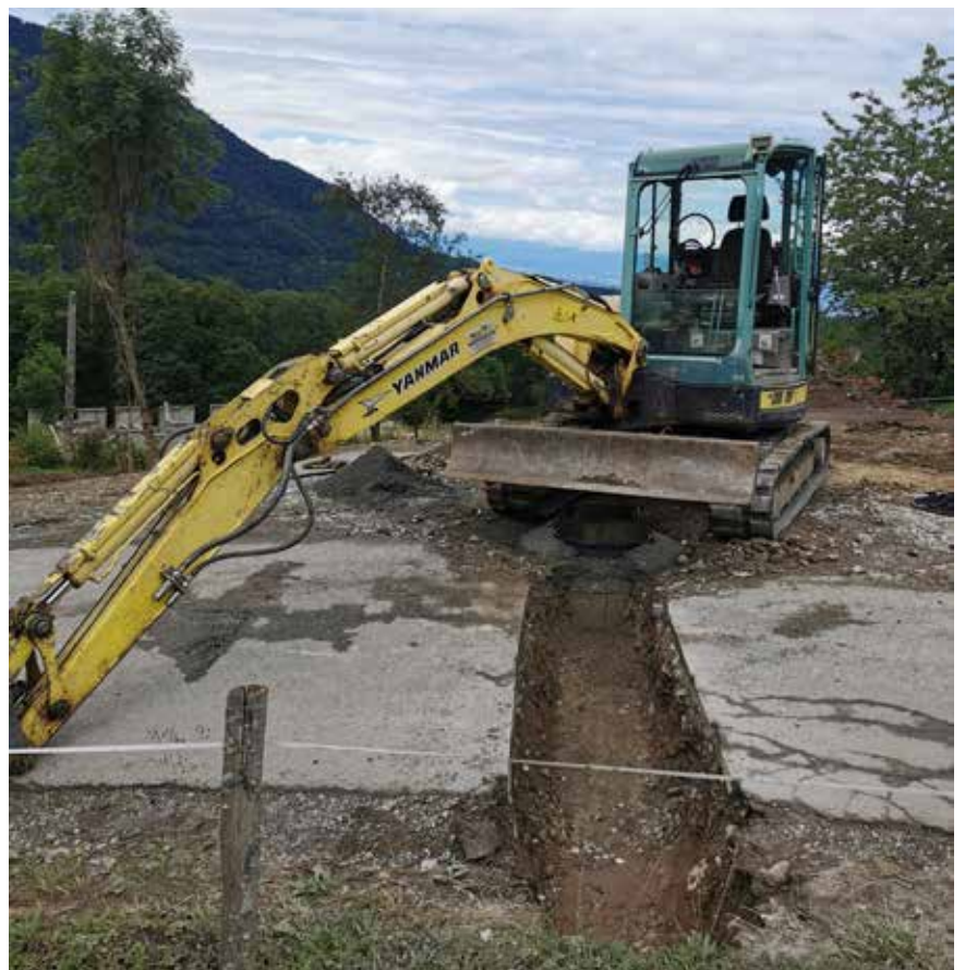
Mise en place d'une grille en amont du talus
