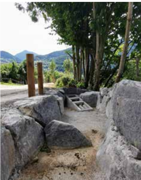
Création d'un piège à cailloux
