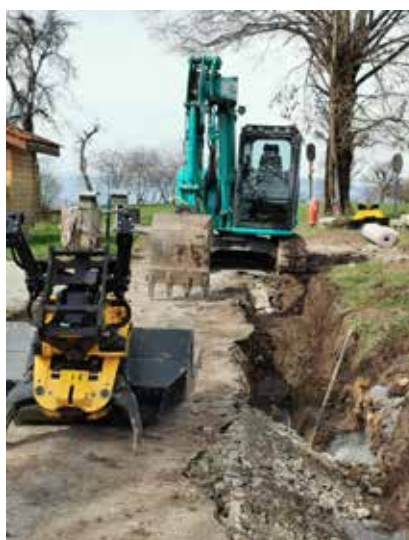
Tranchée pour installer le futur réseau pluvial
