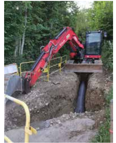
Pose de réseau chemin amont de l'impasse
