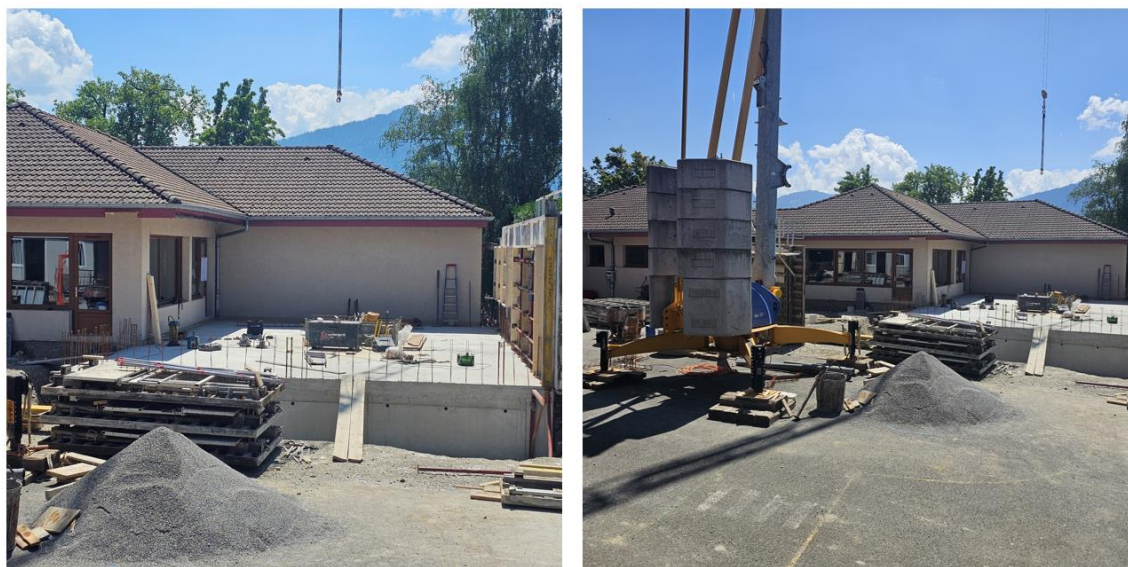
Coulage des semelles, suivi de la construction du vide sanitaire et du coulage de la dalle de l'extension
