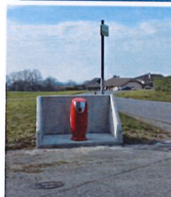
Remplacement poteau incendie Lesvaux 8'200€
