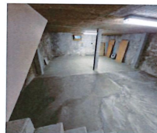
Aménagement cave salle Léman : création dalle 8'000€
