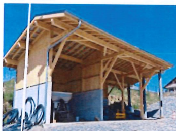
Maçonnerie abri sel + rangement ST 45'000€
