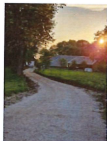
Remise en état chemin Sur La Chaux + EP 11'940€
