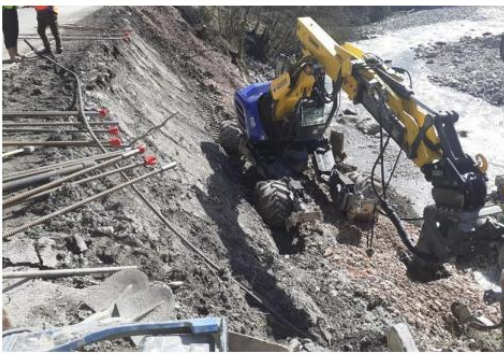
Début de réalisation des micro pieux
