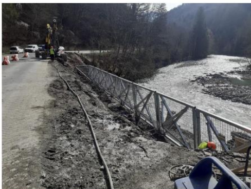
Fin de mise en œuvre des acrosols
