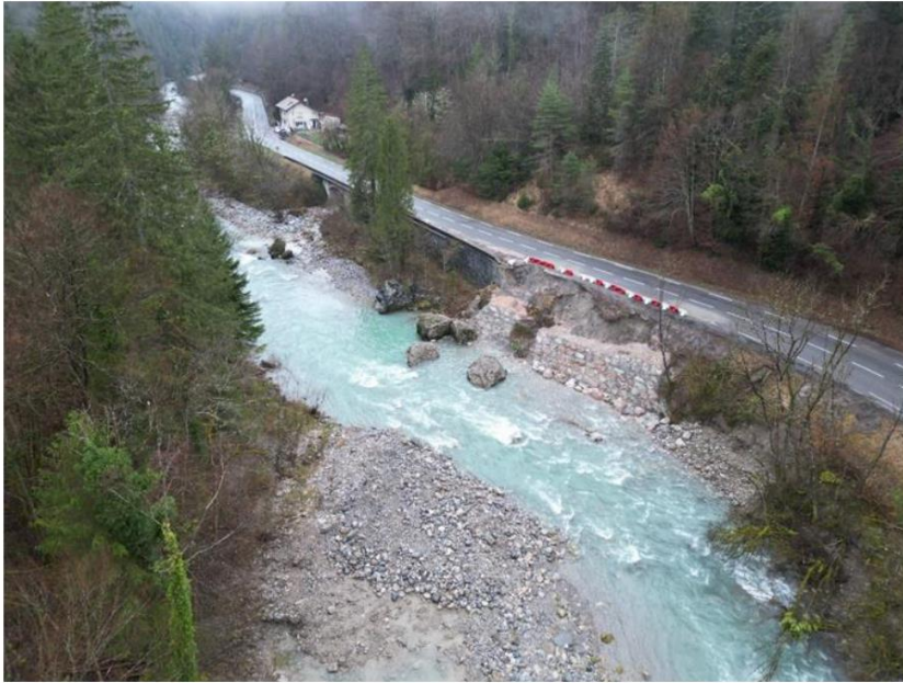
Enrochements maçonnés achevés
